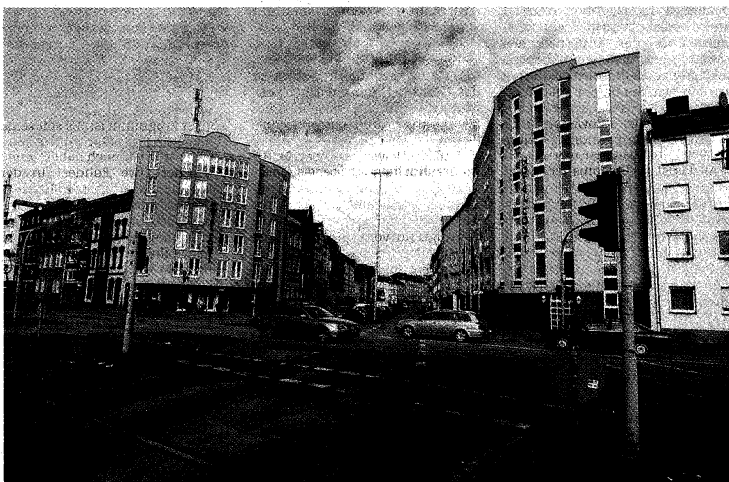
So sieht das Conti-Hotel an der Ecke Düsseldorf Straße/ Kremerstraße heute aus. Um von der Rezeption zum zweiten Gebäudeteil zu gelangen, müssen Gäste bislang die Straße überqueren .
